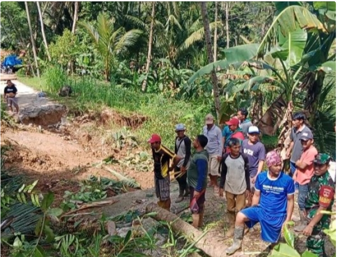
Babinsa Koramil 22/Ayah Peltu Donny Eko Prasetyo mendatangi lokasi bencana alam longsor yang mengakibatkan jalan desa terputus di Desa Karangduwur
